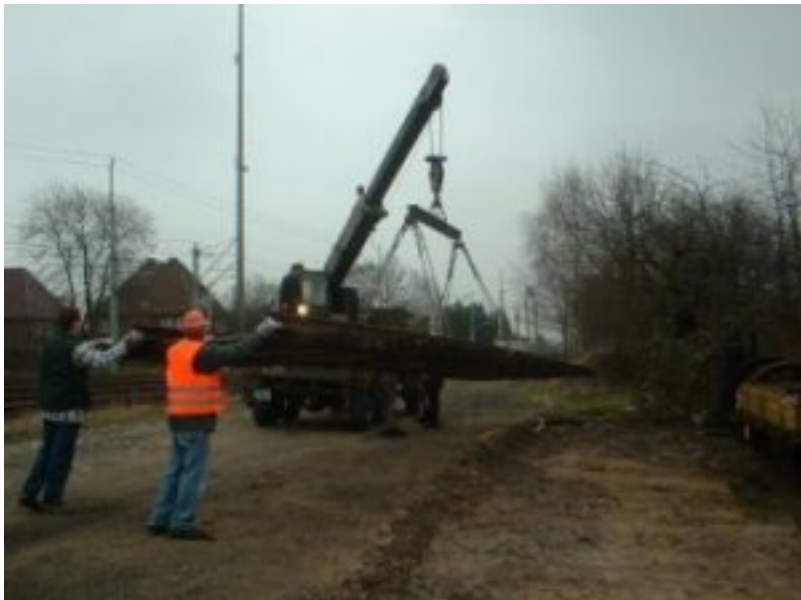
Kranführer Martin Schadewald schwenkt das Gleisjoch an die richtige Position. Jürgen und Jan Friese sorgen dafür, daß es nicht außer Kontrolle gerät.
